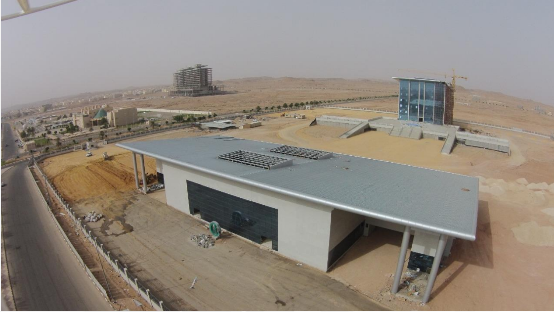
شكل رقم (٨): مجمع مباني أمانة منطقة الجوف أثناء الإنشاء - المشروع بالكامل [١٥]
