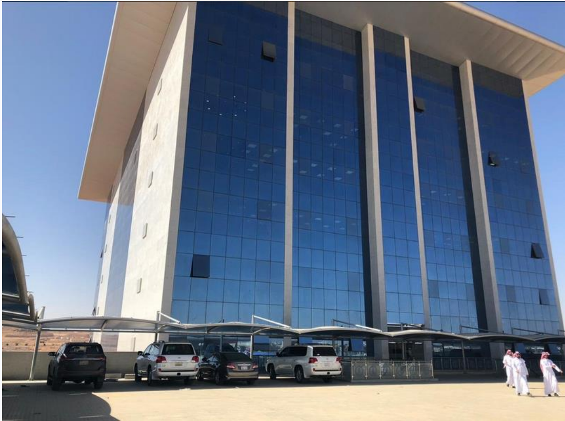
شكل رقم (٩): مجمع مباني أمانة منطقة الجوف - صورة من الواقع بعد انتهاء الإنشاء [١٥]
